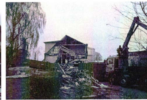
Fra nedrivningen, november 2016
