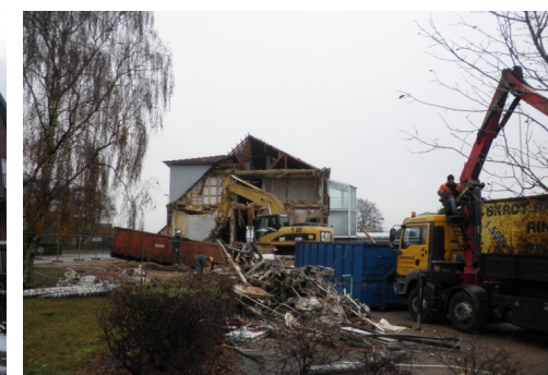
Fra nedrivningen, november 2016
